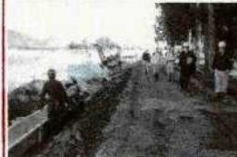
資材吊り作業：クレーン機構のバックホウでの作業はクレーンモード
