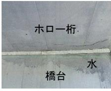
ホロー桁（プレキャスト）裏面のひび割れ 水・塩化物の浸透
