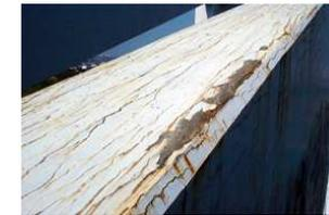
JR東日本がアルカリシリカ反応対策を変更・強化した背景には、**JIS規格に適合した生コンを使用したのにも関わらず、アル骨が原因とみられる劣化が一部で発生しており、ある構造物では劣化破損（過大なひび割れ）が発生した。**
