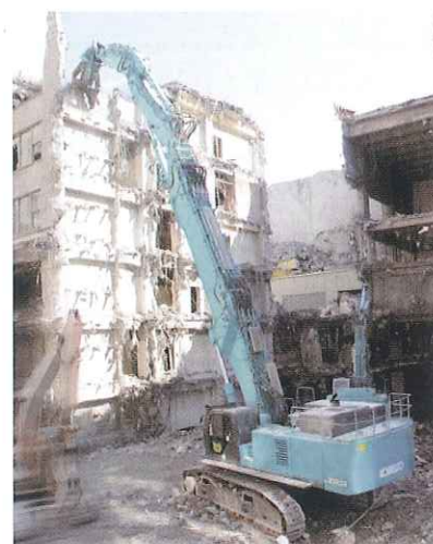
特定解体用機械のコンクリート圧碎機 コベルコ建機株式会社製、同社提供
